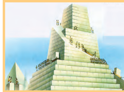
Χρήση κεκλιμένου επιπέδου για τη μετακίνηση ογκόλιθων.
